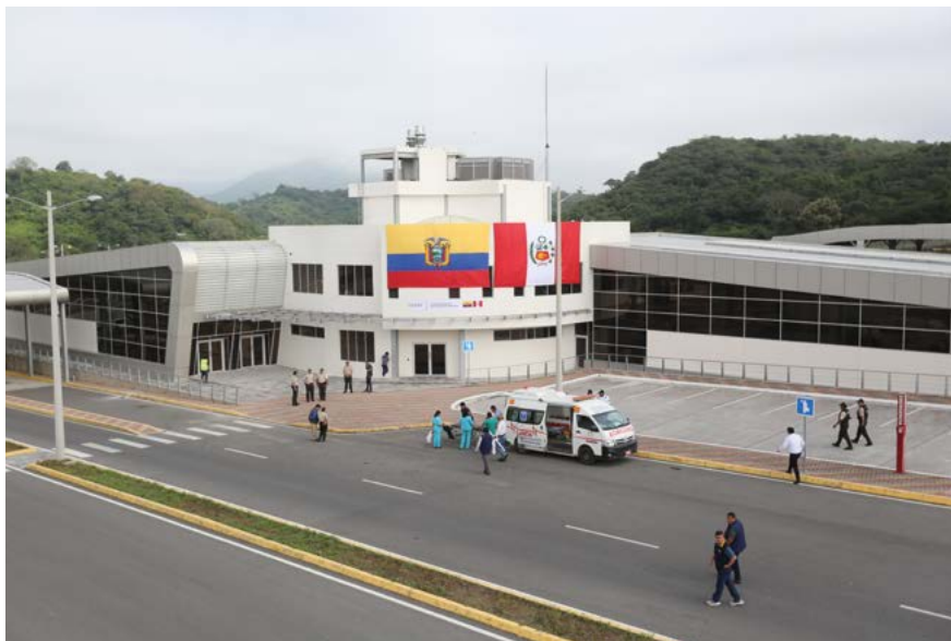
Centro Binacional Macará inaugurado el 14 de junio de 2023. Da atención migratoria, de aduanas, control fito y zoonosanitario, entre otros.
